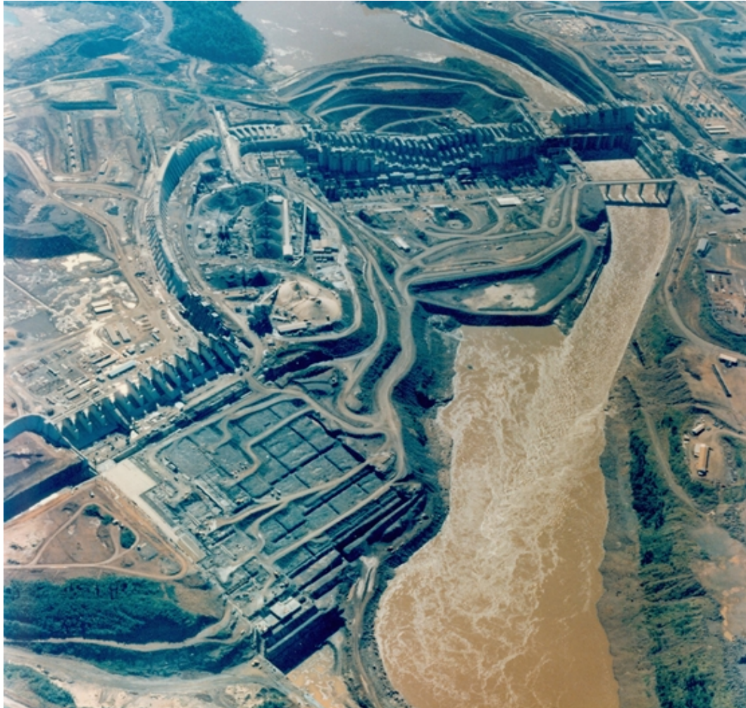
Figura 2. Obras de Itaipú. Fuente: Diario Itaipú Electrónico.
